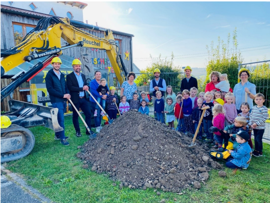
Gemeinsamer Spatenstich der Projektbeteiligten und den Kindern und Erzieherinnen des Evangelischen Kindergartens.
